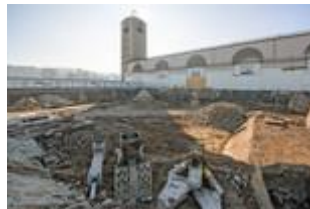
Die Baugruben für die neue Bahnsteighalle unmittelbar am Bonatz-Bau.
